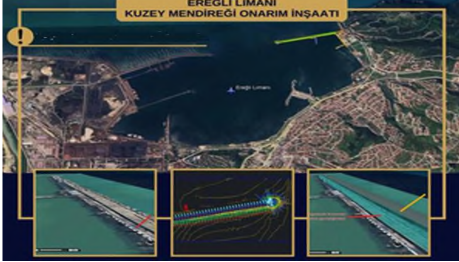
Resim 25 Mendirek Onarım ve Tadilatları
